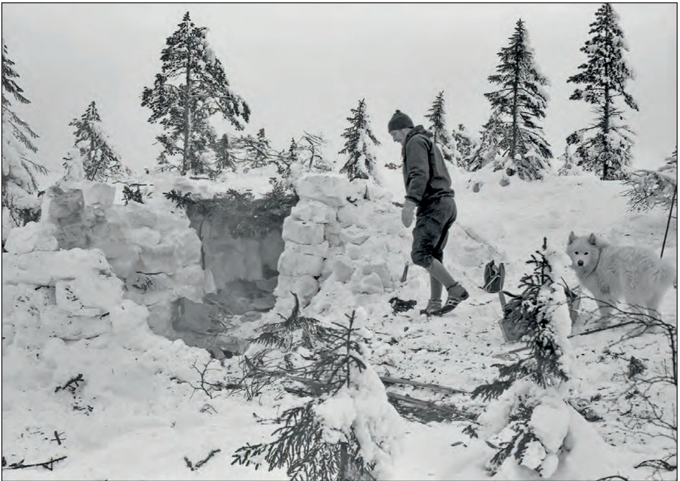
Det nedraste taket måtte repareres med rajer og snø på toppen.
