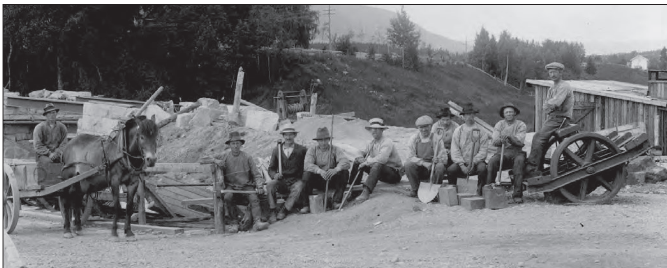
Fra byggingen av Mo-brua ca. 1920. Fra venstre: Håkon Kirkemo, Jørgen Bekken (Mellomberget), Arnt Vik, Hans Solvang, ukjent, Polmar Haugen, ukjent, ukjent, Anton Sannerud og Peder Stenberg (Amundsen). (Kulturminnelagets fotosamling)
