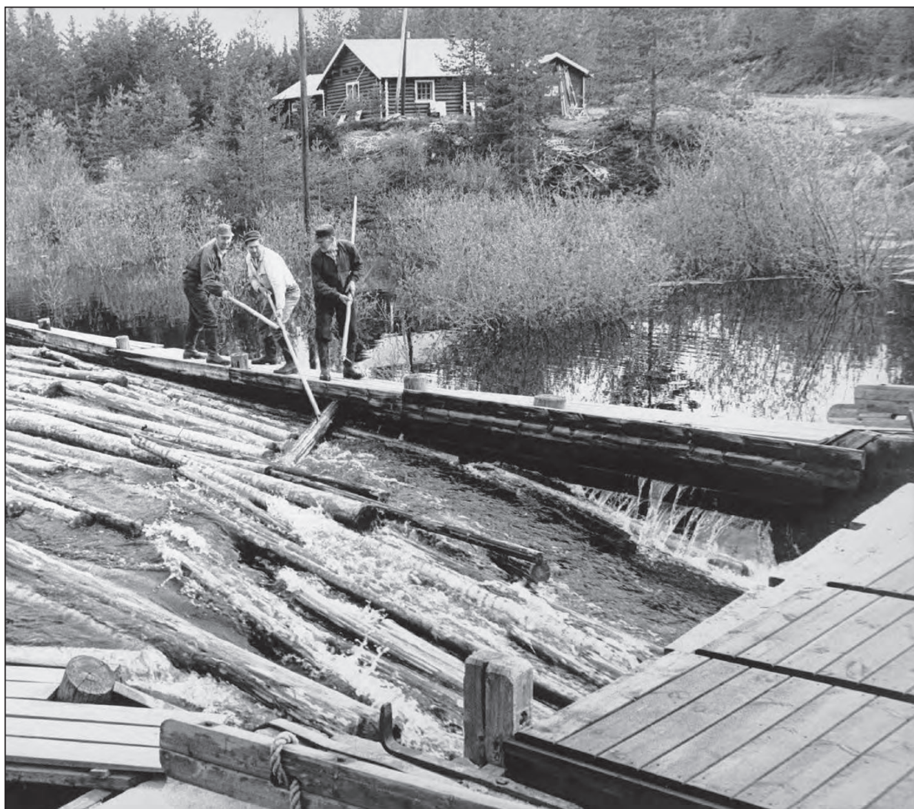
Fra Mattisdammen: På dambrua, nederst i høyre hjørne, ser vi damlukene som ble brukt til å magasinere vann. På ei bru bak plankeskjermen som skulle lede virket mot damåpningen og det nedenforliggende vassdraget, er tre fløtere i arbeid med haker: Julius Myrhagen, Jonny Lishagen og Jørgen Lishagen. (Foto: Brynjulf Aarthun, Aftenposten / Anno Norsk skogmuseum)
