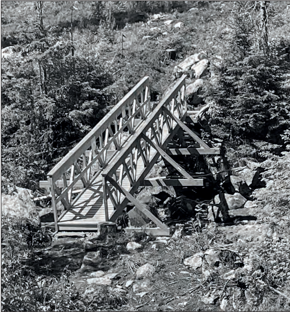
Den nye brua over Austvassåa nord for Bakkefløyta ble høytidelig åpnet av ordføreren 25. juni. (Foto: John Ellingsen)
