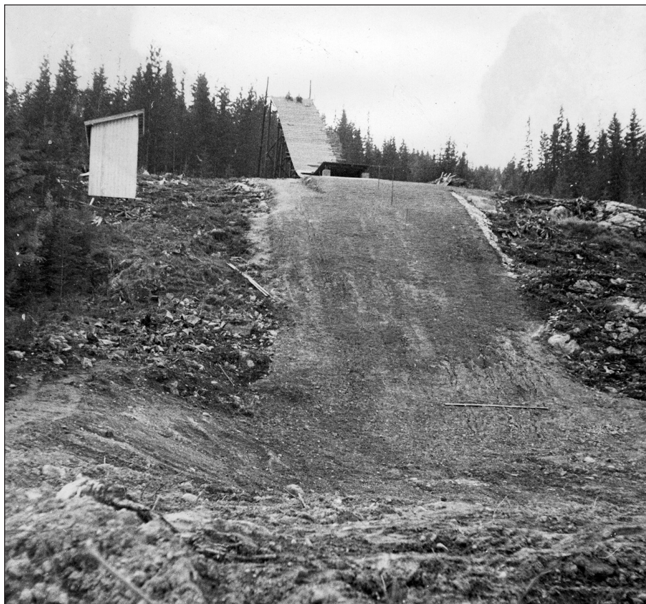
Anleggsarbeider i Knappåsen i 1961.
