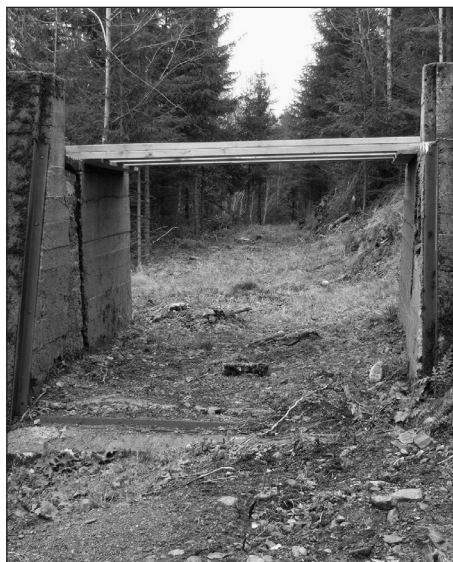
Hestvegen ble lagt gjennom Mørktjennsdammen.
