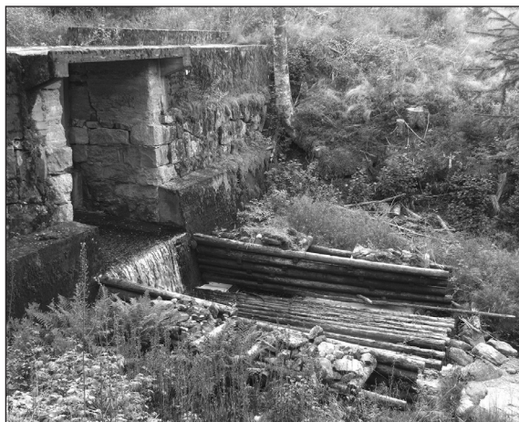
Mørktjennsdammen med skådammer og golv (sluse). Til høyre: Dammen med nye Høsbjør i bakgrunnen.
