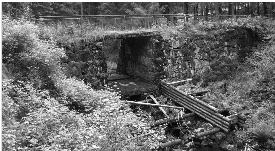
Mosemyrdammen med skådammer, golv er fjernet
