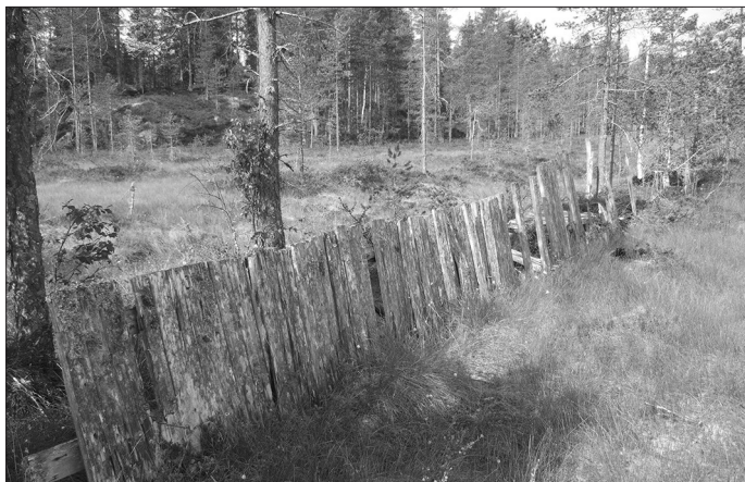
Rester av attholdsdammen ved Tannsjøen i dag.
