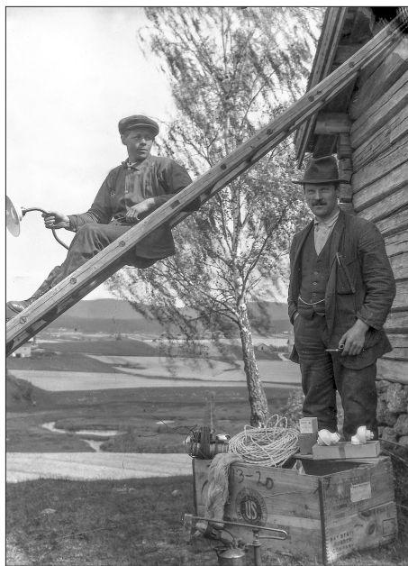
Installatør Per Sutterud (t.h.) og Ole H. Bjørnstad legger inn strøm på Bjørnstadhau- gen i Rud i 1920.
